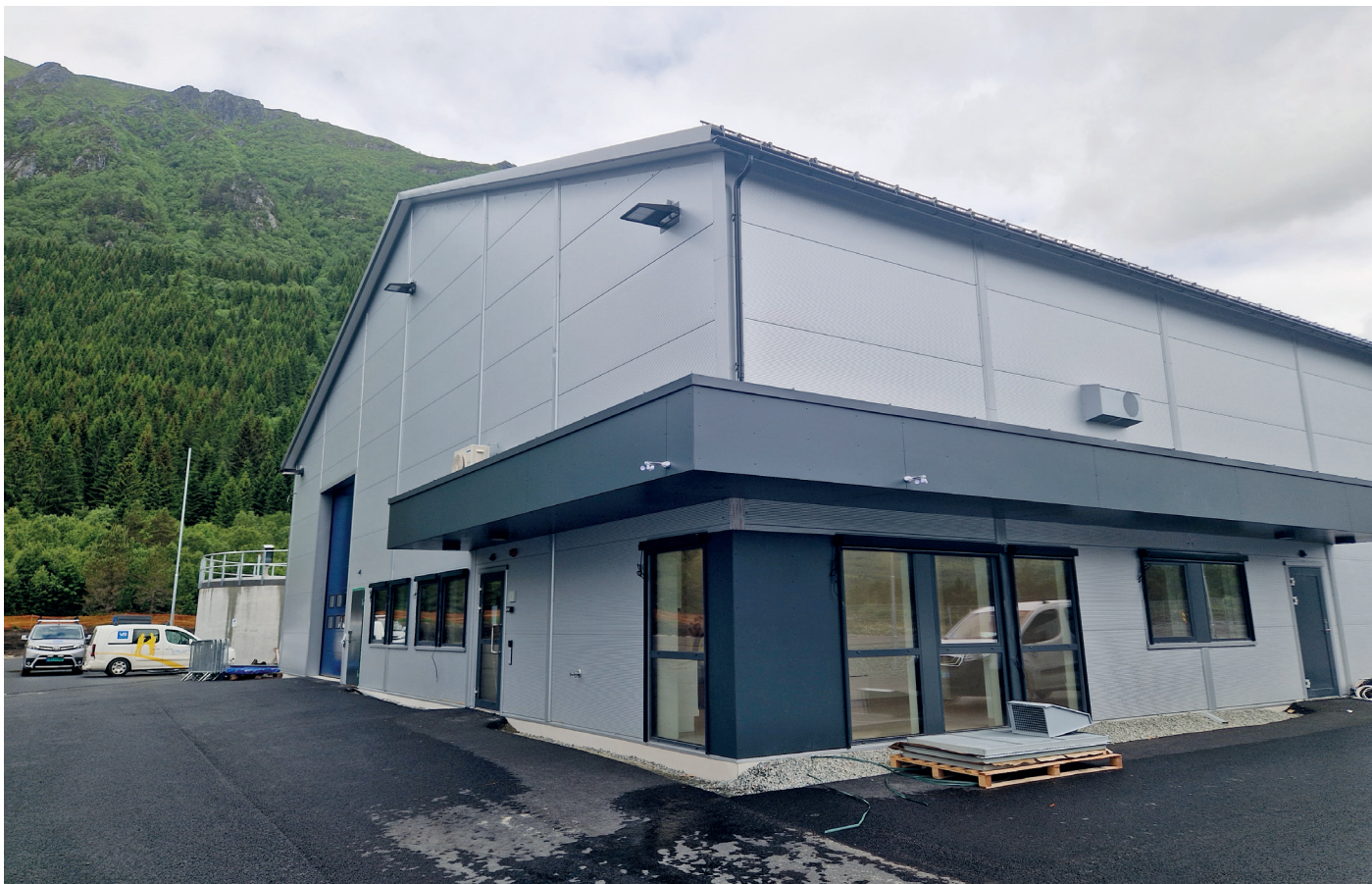
I dette hjørnet av bygget blir det kontorer.
