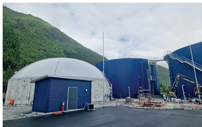
Den kuleformede sekundære prosesstanken til venstre og de to store prosesstankene bak.
