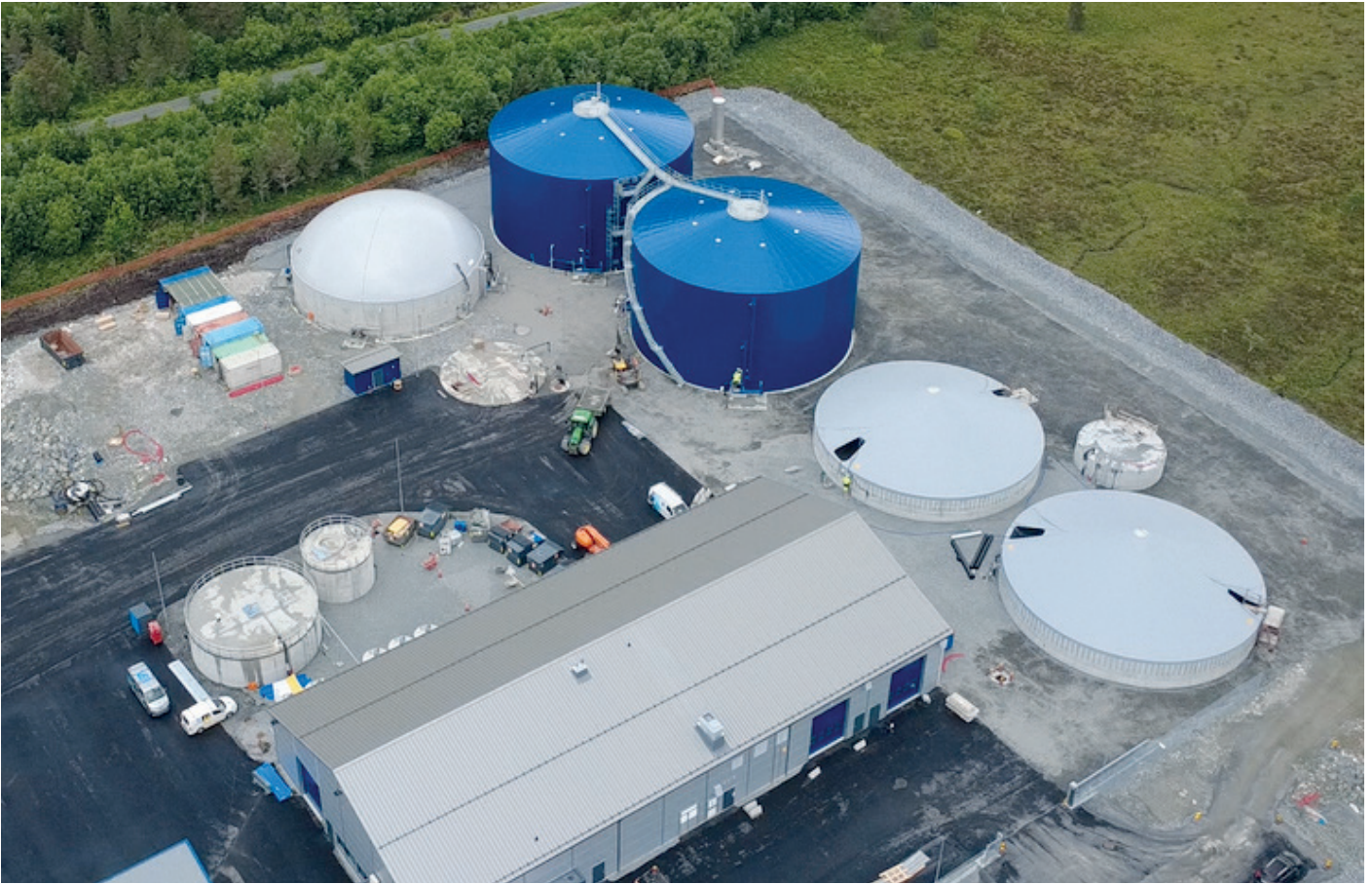
De store blå prosessstankene er godt synlige på anlegget.
